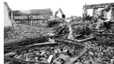
– Нам поступил заказ на демонтаж здания. В целях безопасности зона работ ограждена по всему периметру, – поясняют строители. – На работы потребуется примерно две недели. Параллельно с демонтажем осуществляют вывоз боя и строительного мусора. В планах убрать постройку и максимально выровнять площадку по уровню земли. Кирпич уже превратился в труху. Экскаватору достаточно было только тронуть стену, как она обвалилась. А вот фундамент здесь достаточно серьёзный.
